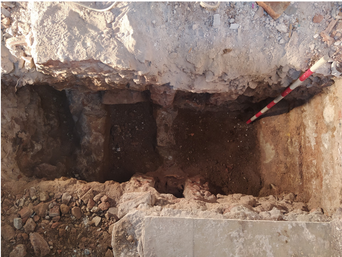
Fig 24. Vista en planta del rebaix de la sabata de l'escala. Foto 020_21_48.
