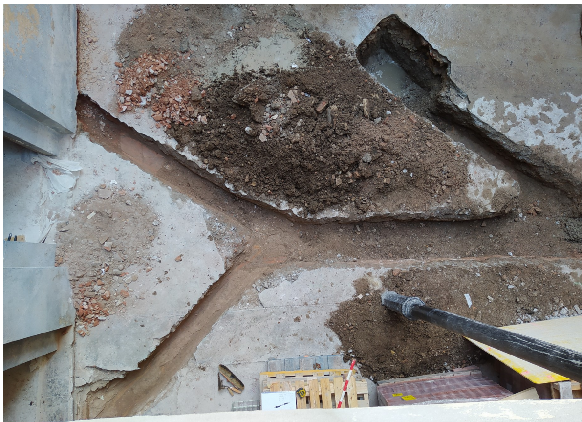
Fig 13. Foto final de les rases 1, 2, 3 i RP al pati intern. Foto 020_21_9.
