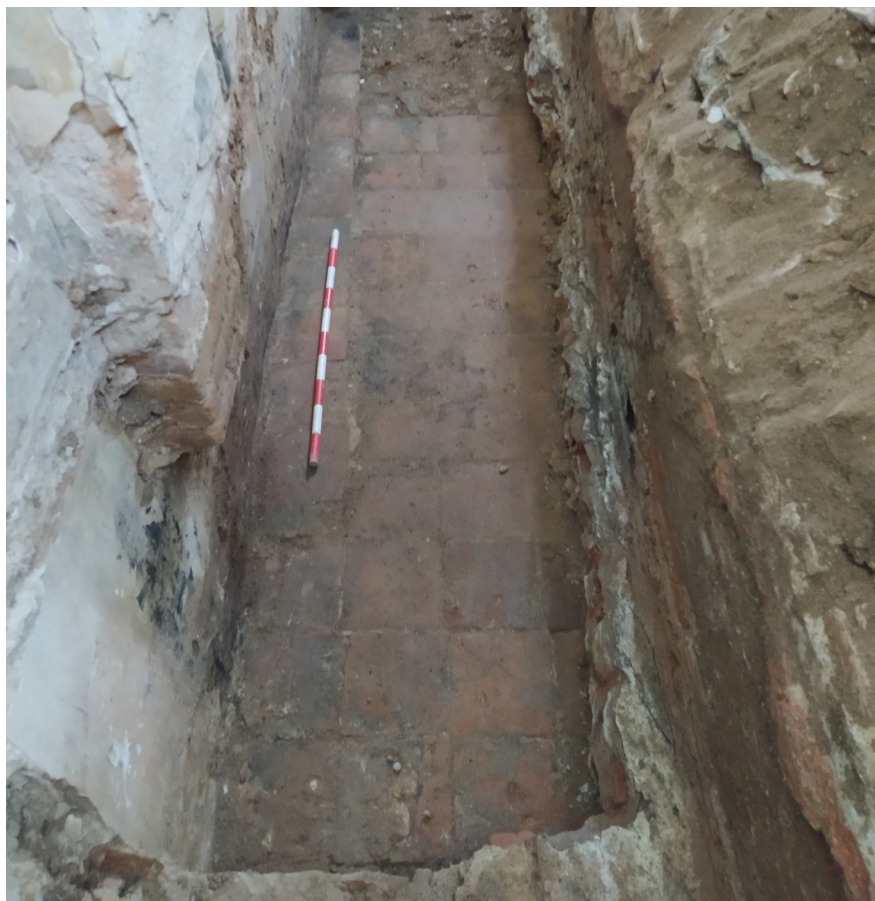
Fig 18. Paviment del soterrani (UE 247). Foto 020_21_41.
